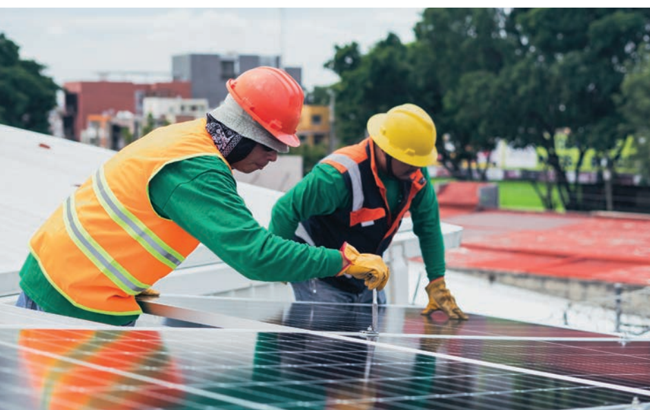
Solar technicians installing solar panels. Los Muertos Crew/Pexels
